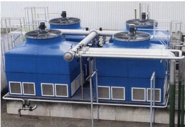
La utilización de Ozono garantiza una desinfección permanente con un importante ahorro en el mantenimiento y el funcionamiento del sistema. Con la eliminación de bacterias y por tanto del biofilm, se mejora el rendimiento, reduciendo el consumo de energía. Al no necesitar regenerar el agua, también se produce un ahorro en el suministro y el mantenimiento. Contaminantes tan letales como la Legionella son erradicados con el Ozono.
